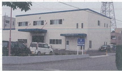
新たに新設された工場。車いすの人も働きやすいようにエレベーターもついている
